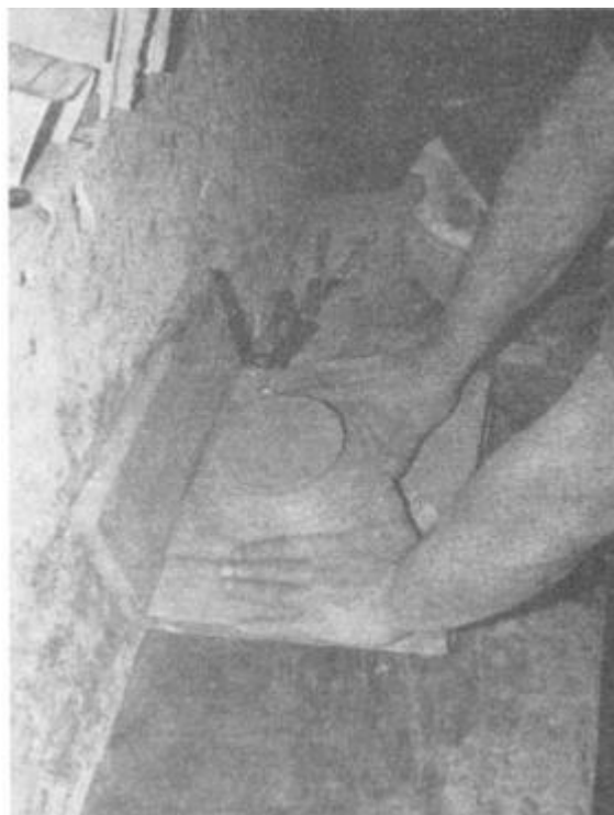
25. ábra A csempezem egyengetése
