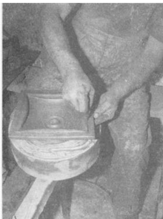
21. ábra A keret leválasztása a kerítővel
